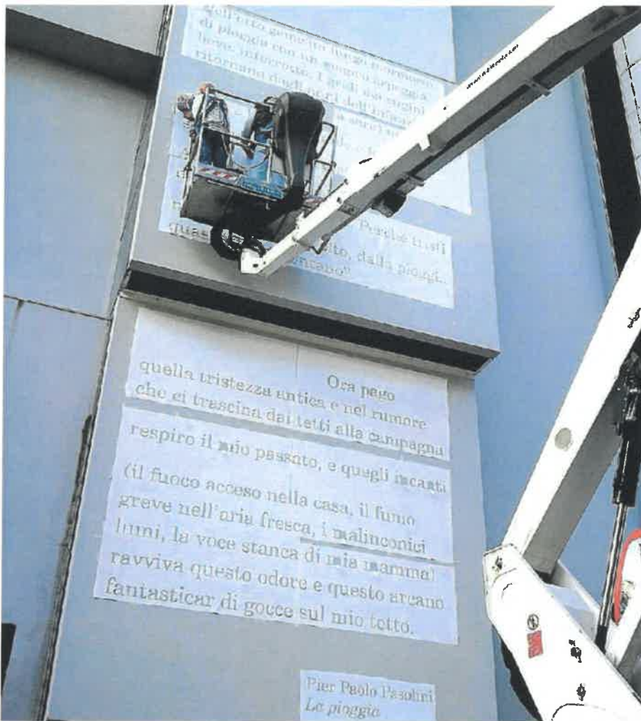
I lavori di installazione della poesia "La pioggia" sulla facciata del teatro Verdi e Pasolini sul set de "La Ricotta"
